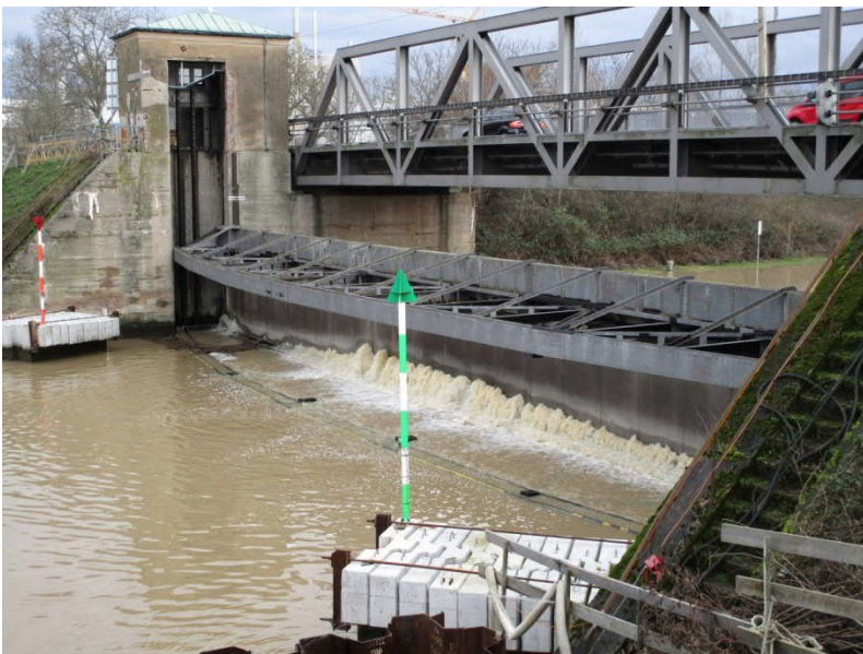
Bild 3: Altes Hochwassersperrtor aus Richtung Unterwasser in geschlossener Stellung und Straßenbrücke (Quelle: Amt für Neckarausbau Heidelberg)
