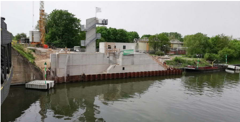
Bild 5: Widerlager Südseite mit und Antriebshaus und Treppenturm zur späteren Begehung des geöffneten Sperrtores (Quelle: Amt für Neckarausbau Heidelberg)
