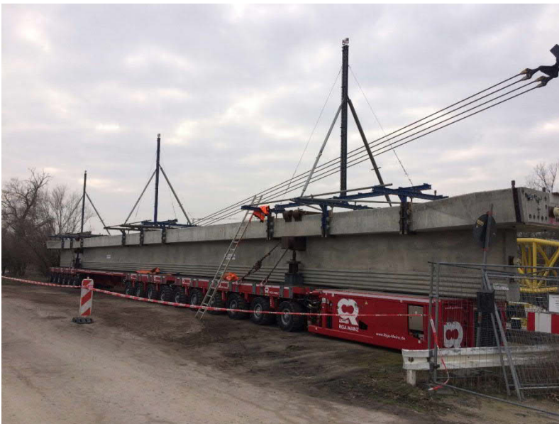
Bild 8: Fertigteildrempel mit bereits montiertem Vermessungsgerüst am Umschlagort (Quelle: Krebs + Kiefer Ingenieure GmbH)
