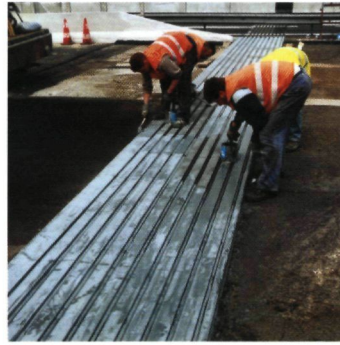
•• Werken op het viaduct van Vilvoorde
