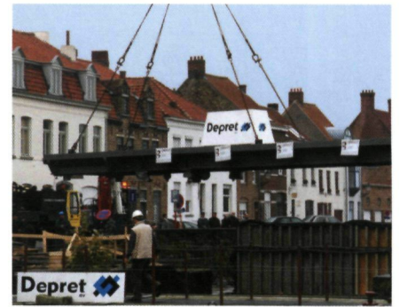
De bouw van de nieuwe Coupurebrug
