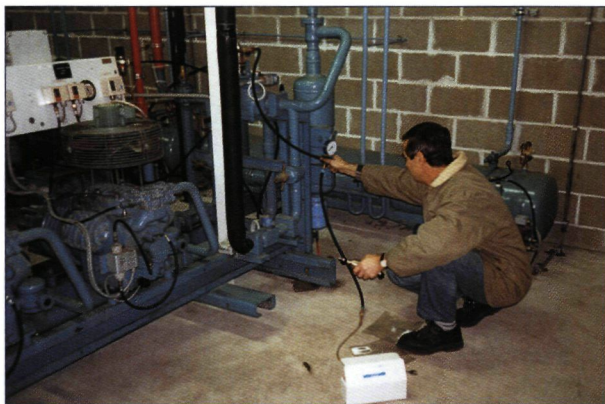
Bemonsteren van koelmiddel bij een koelinstallatie in een grootwarenhuis
