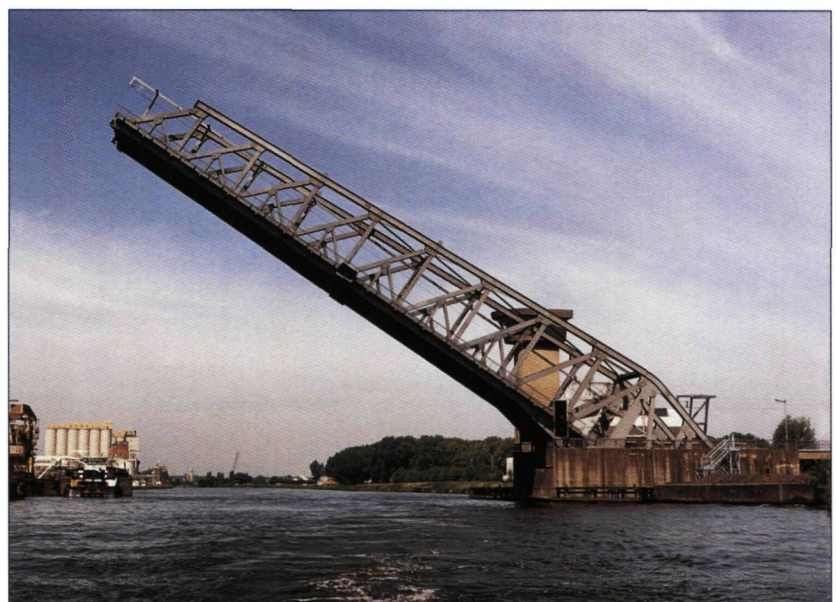
Spoorwegbrug in Ruisbroek
