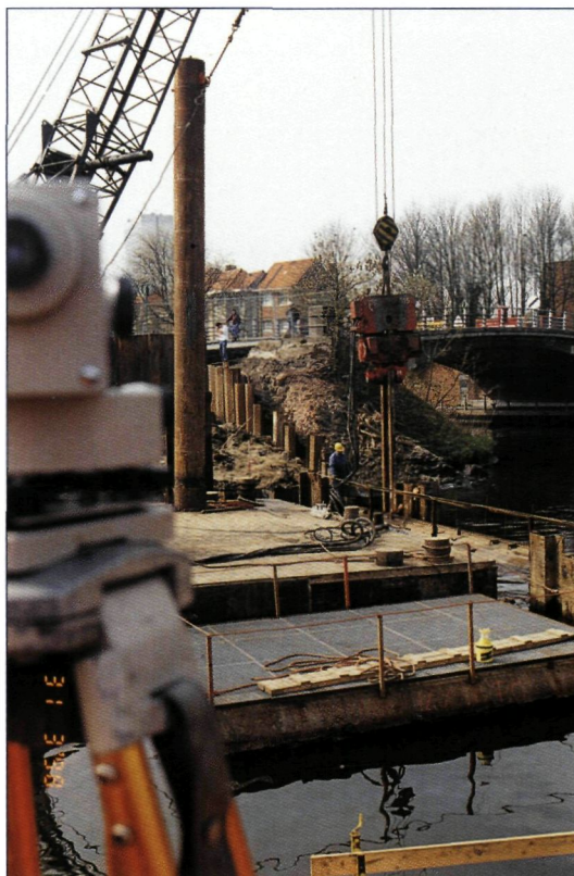
Inheien damplanken van bouwkuip zinker, voor de afwaarts te bouwen nieuwe Dambrug
