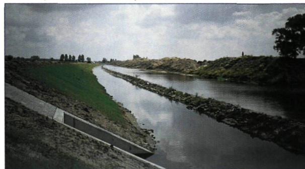
Kanaal Gent-Oostende te Beernem: rechteroever met zicht op plasberm in opwaartse richting
