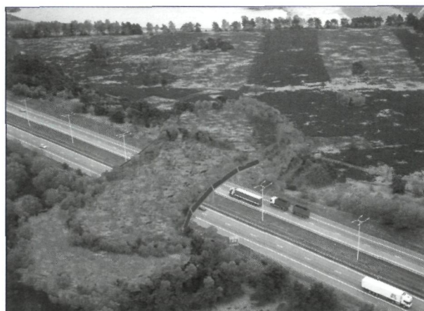
Een ecoduct: één van de noodzakelijke voorstellen om de E314 voor grote zoogdieren te ontsnipperen (Mechelse Heide, Maasmechelen). Bron: Technum nv
