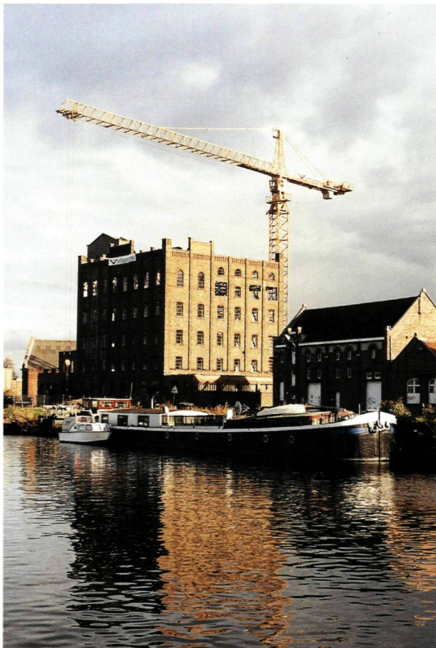
De traditionele economische activiteit langs het kanaal is verdwenen. Het geven van een woonfunctie aan de voormalige 'Bloemmolens Dewulf' (Brugge) moet het beeldbepalend karakter van deze oude bedrijfsgebouwen vrijwaren en versterken en kan een aanzet zijn naar een volledige herwaardering van de kanaaloever.
