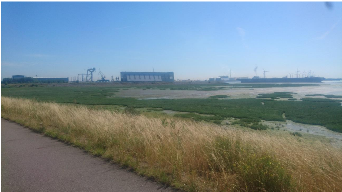
Foto 42: Sloehaven, Overzichtsfoto, Oost-zuidoostelijke richting
