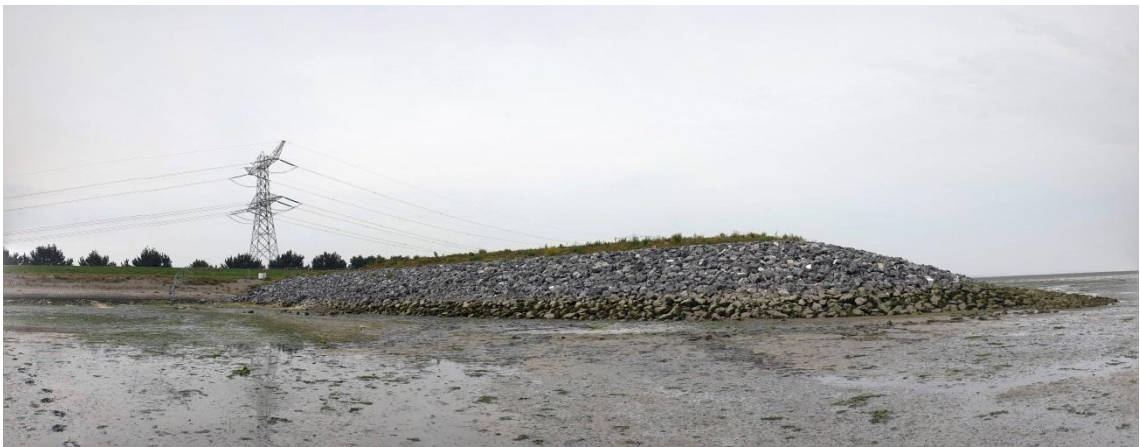
Foto 36: Zuid-Beveland, Opgeworpen stenen dam
