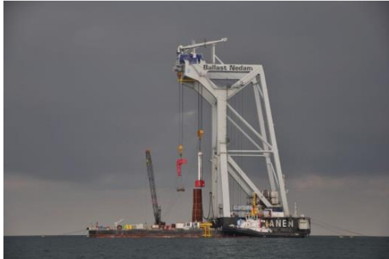
Figuur 2.70. Het heien van de funderingen van offshore windturbines genereert hoge onderwatergeluidsniveaus.
