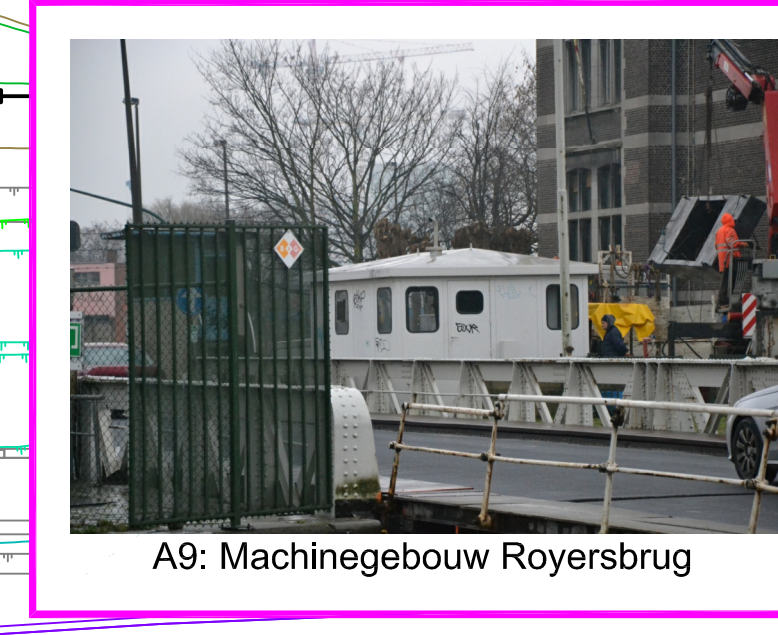
A9: Machinegebouw Roeyersbrug
