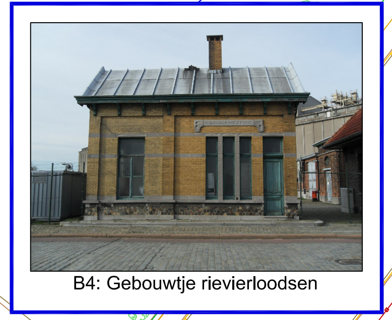
B4: Gebouwtje rivierloodsen
