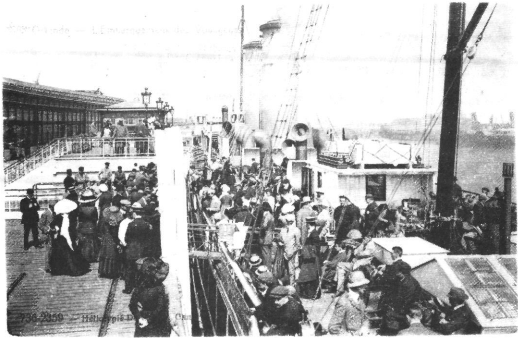
10. 1912 - Inscheping van passagiers op het t.s. "Jan Breydel". Bemerkt in de achtergrond op de kaai, de typische inschepingstoren, met platformen op drie niveau's.
