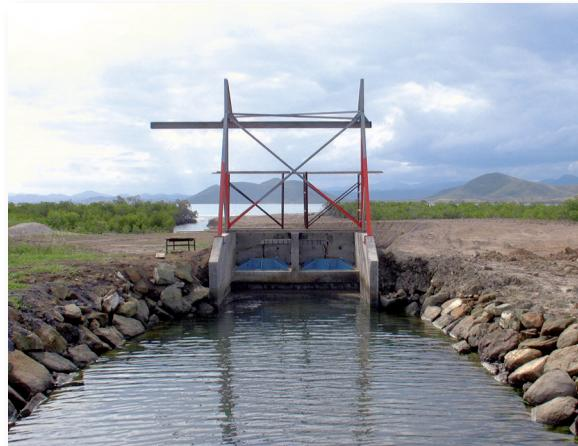
Photo 2 – Station de pompage d'une ferme familiale avec son portique de levage
