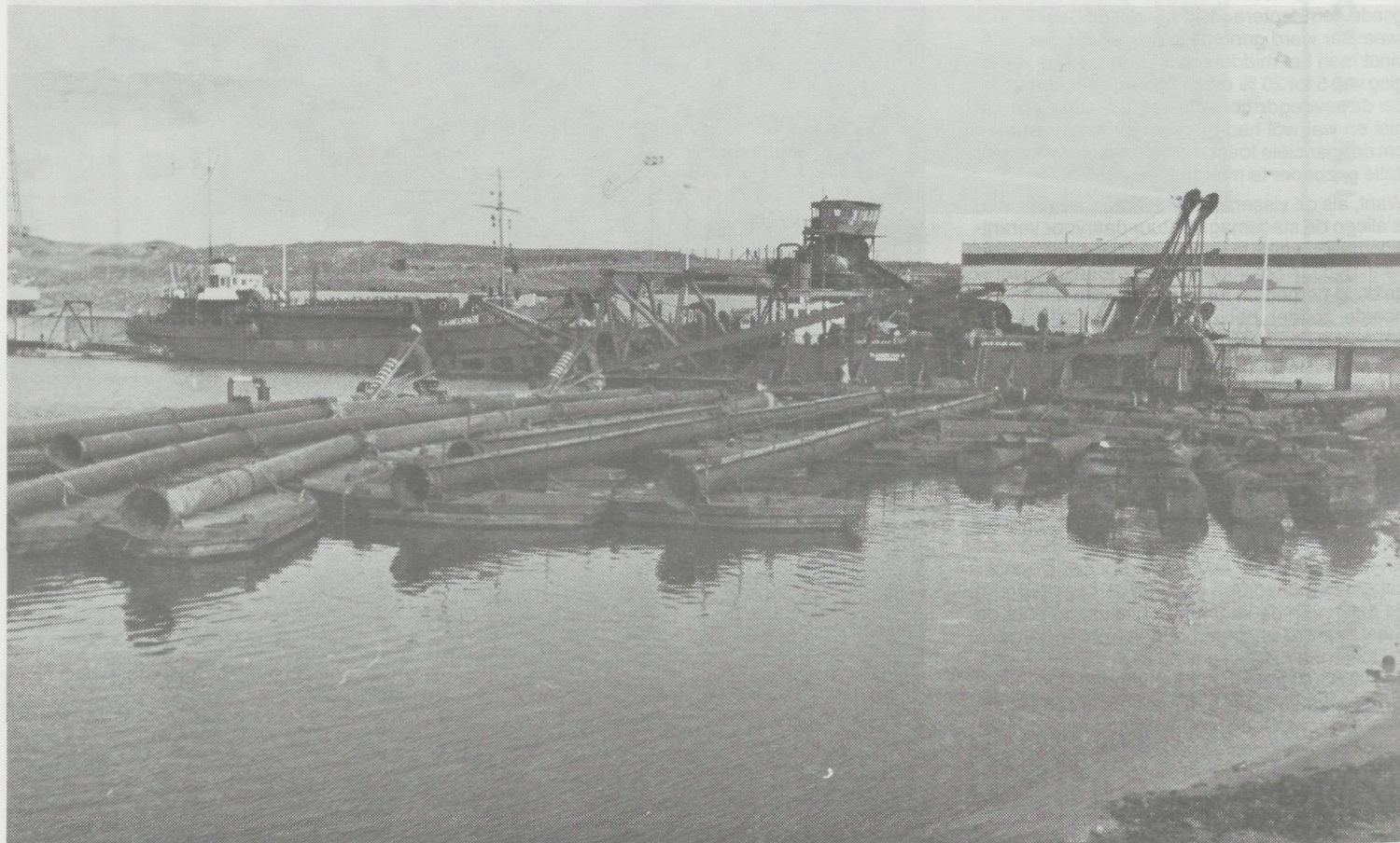
De „Vlaanderen IV”, de „Vlaanderen XI” en de „Volkracht IV” gemeerd in het nieuw visserijdok te Oostende met op de voorgrond de buizeninstallaties van de Firma Baggerwerken Decloedt. De vaartuigen en de buizen samen nemen een groot deel in van het vissersdok dat bestemd was voor... de visserij.
