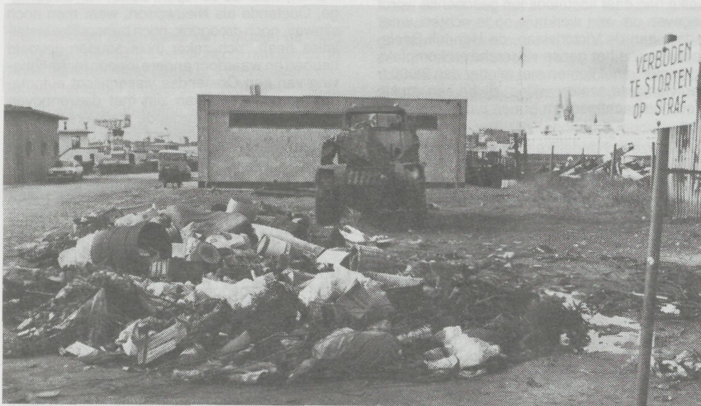
De gronden nabij de slipway in de Oostendse vissershaven. Niettegenstaande het „Verbod tot storten” is daar toch een fikse vuilnisbelt ontstaan.
