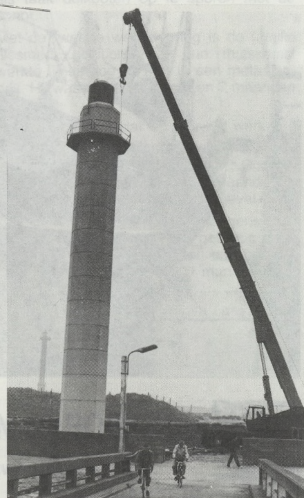
In amper vijf dagen werd de 31 m. hoger onbemande radartoren in Oostende geplaatst. De konstruktie, opgebouwd uit geprefabriceerde elementen, wordt vol-gend jaar bekroond met een radarinstal-latie. (gw)
