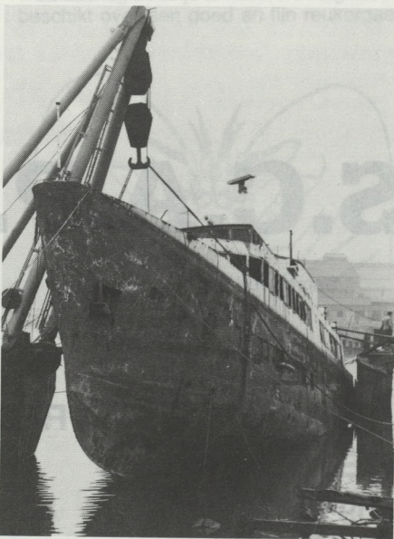
Na een dag en een nacht pompen kwam de Fjordsol al aardig boven water. Daags nadien was het schip al drijvend. (gw)
