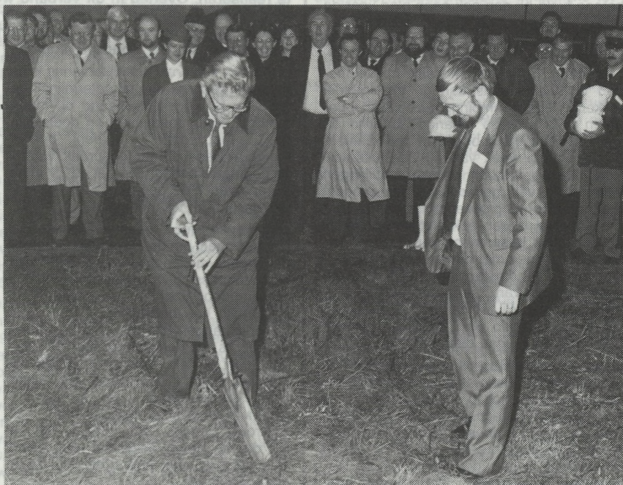
Burgemeester Frank Van Acker plaatst de eerste spade in de grond op de Texaco-terreinen. Met dit symbolisch gebaar werd het startsein gegeven voor de bouw van een diepvriesloods in de achterhaven. (foto gw)
