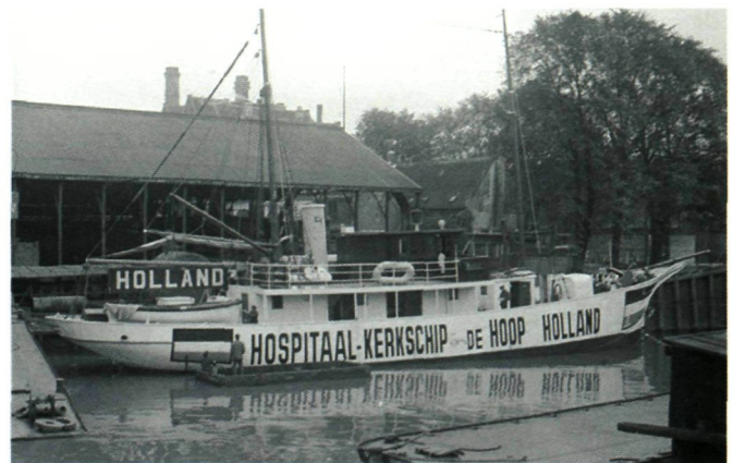
PHKS De Hoop II de laatste werkzaamheden met de kwast
