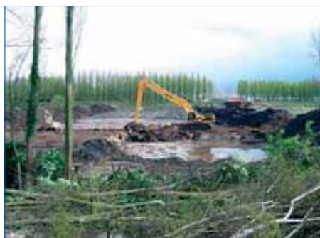
Aanleg van het Gecontroleerd Overstromingsgebied Kruikeke-Bazel-Rupelmonde.
