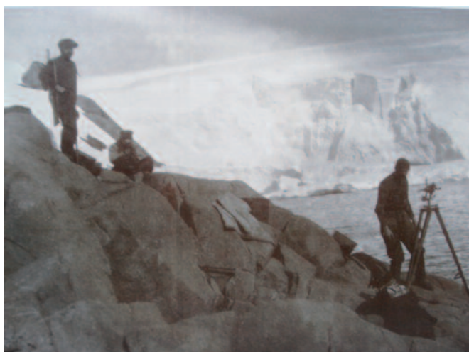
Figure 7. Débarquement Monts Solvay – Mise en station du théodolite Brunner (Expédition A. de Gerlache)
