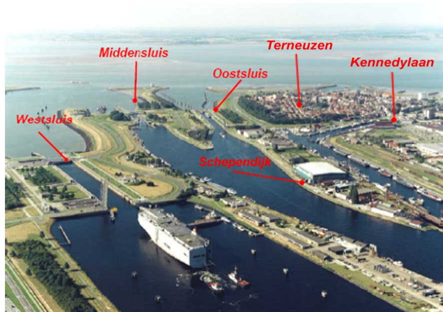
Figuur 2-2 Overzicht Sluisencomplex Terneuzen
