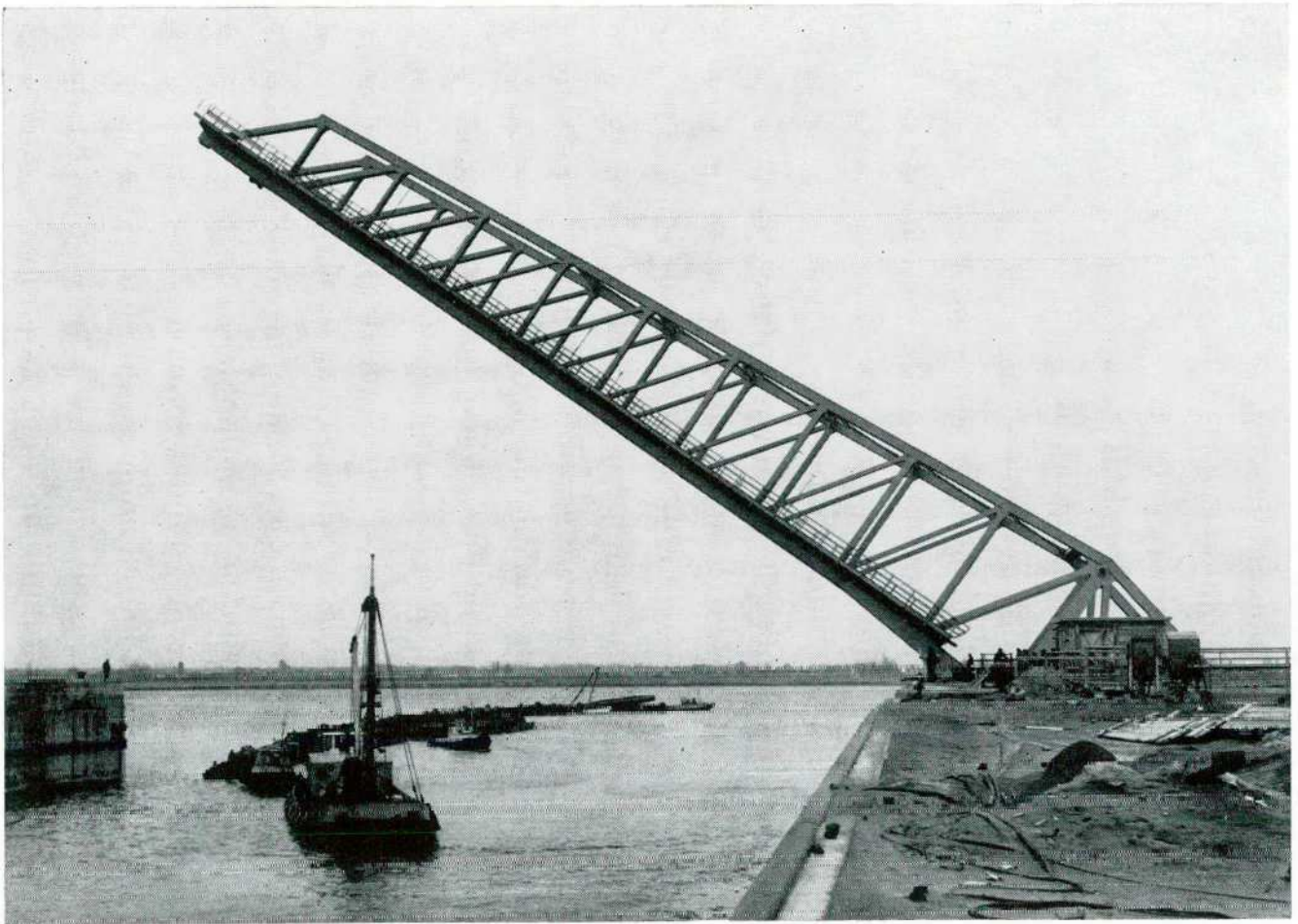
Ecluse de Zandvliet : Pont à la tête aval. (20.2.1967)
