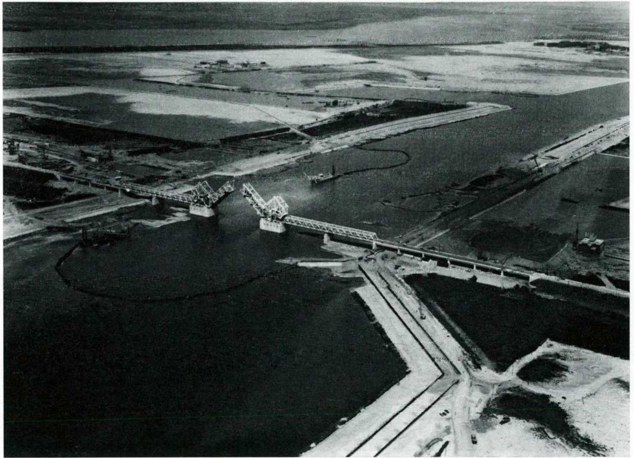
Aerial photograph Canal-Bridge Luchtfoto Kanaalbrug (8.6.1967)
