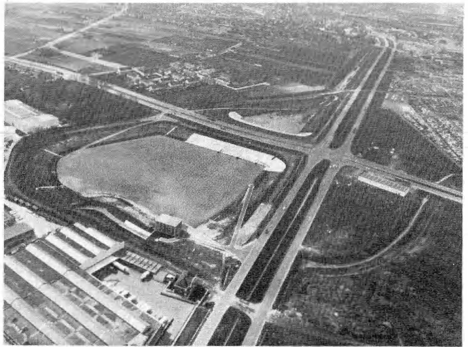
FOTO 1. Onweersbekkens op de Woluwe te Machelen-Vilvoorde. Bekkens Noord en Zuid, aanvoerkanaal en pompstation.
