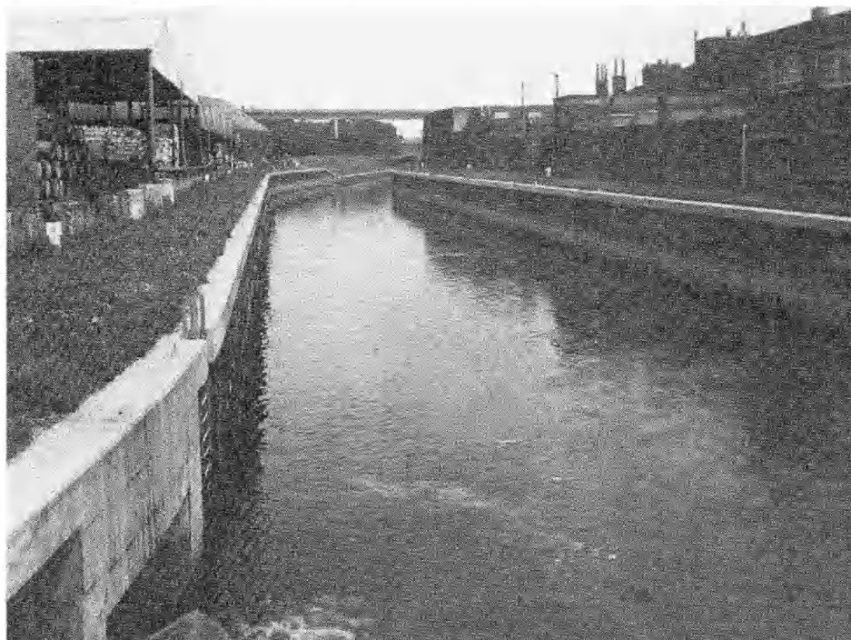
FOTO 2. Zenne — Profielverruiming afwaarts de Budabrug te Brussel - Vilvoorde.
