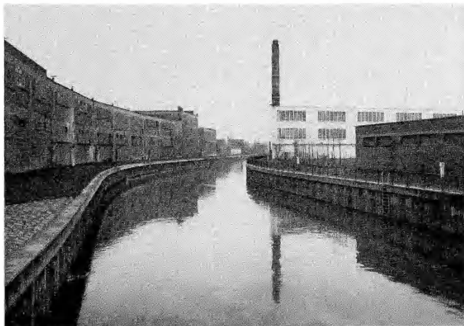
FOTO 3. Zenne — Profielverruiming afwaarts de Sluisstraatbrug te Vilvoorde.
