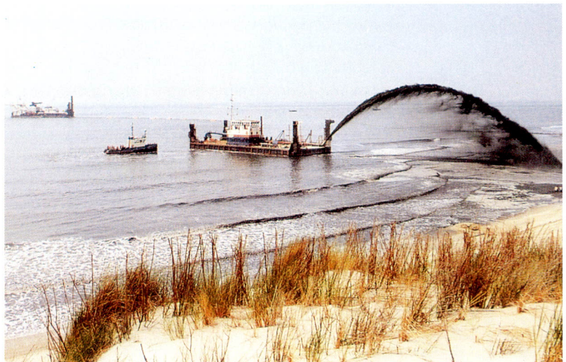
Fig. 4.24 Uitvoering van een vooroever- en strandsuppletie.
