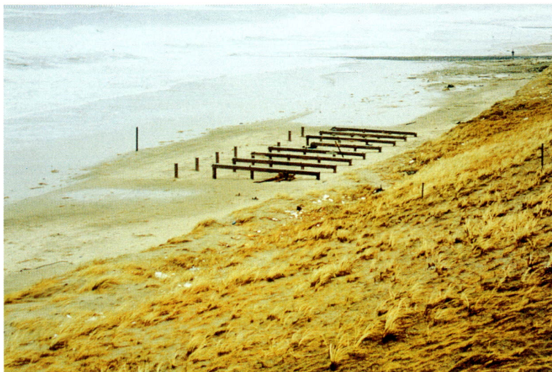
Fig. 5.11 Kunstmatige verhoging door middel van een paalfundering.
