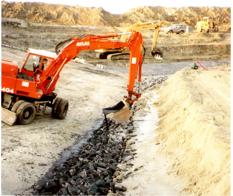
Fig. 7.14 Ingieten van de teenconstructie met gietasfalt.
