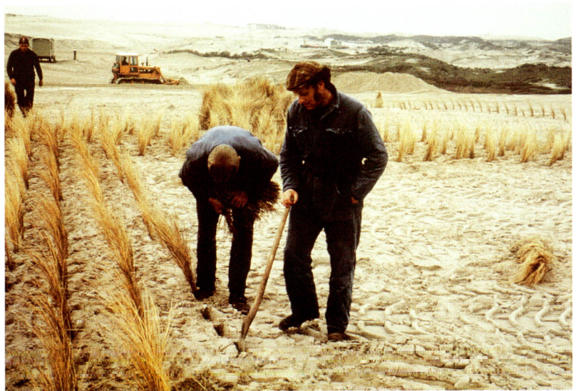
Fig. 7.11 Aanbrengen van helm om het gesuppleerde zand vast te leggen.
