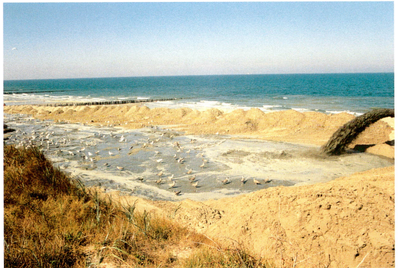
Fig. 4.17 Uitvoering van een strandsuppletie.
