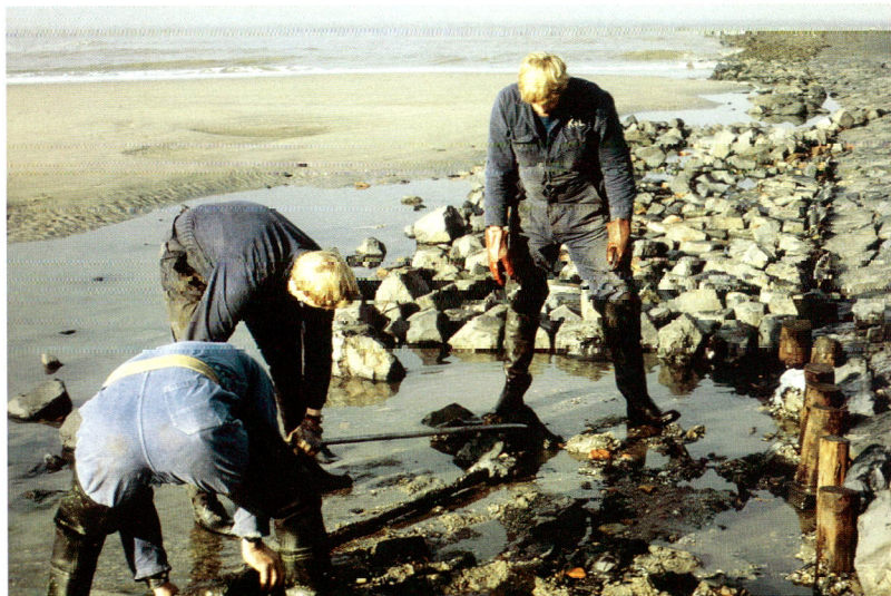
Fig. 7.13 Onderhoud van een strandhoofd; herzetten van een steenzetting na schade door stranding van een schip.
