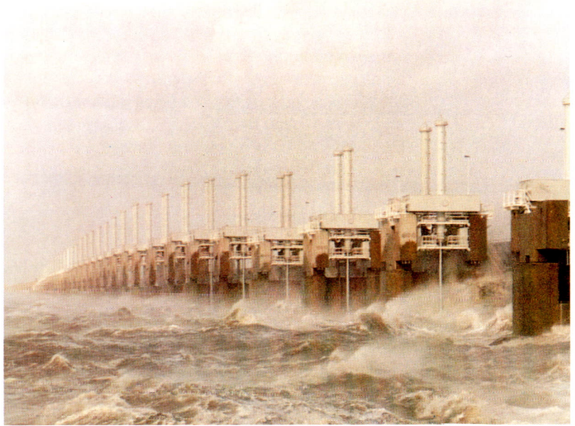
Fig. 3.3 De stormvloedkering in de Oosterschelde.
