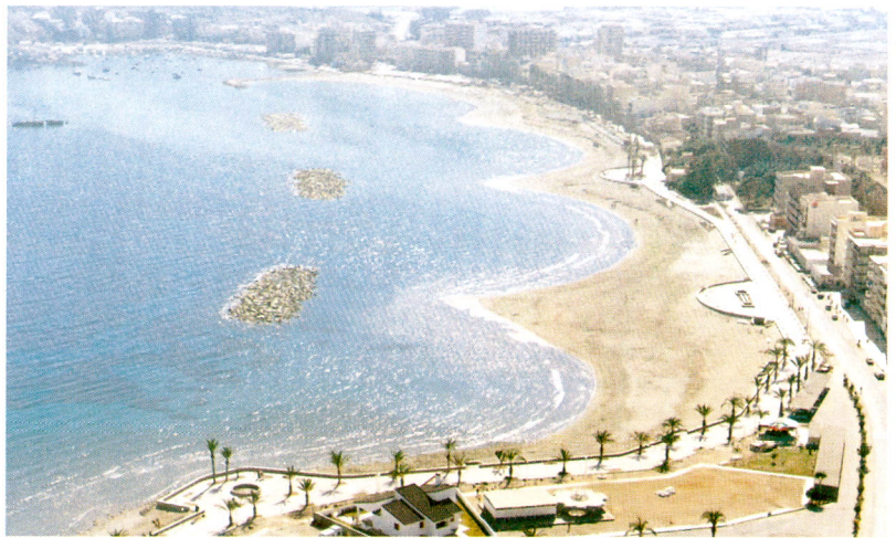
Fig. 4.58 Beïnvloeding van de ligging van de kustlijn met behulp van een (onderbroken) dam op de vooroever.
