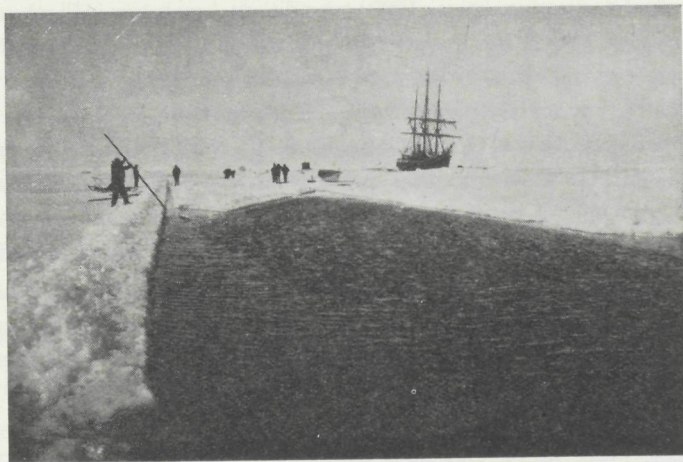
16. L'achèvement du canal qui avait près de 700 m. de long. (Photo prise le 30 janvier 1899)
