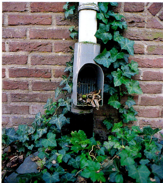
Afgezaagde regenpijp met bladvanger.
