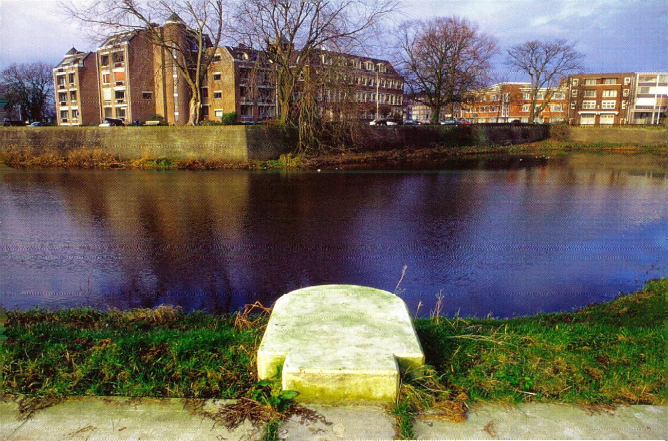
Een van de twee inlaatwerken van het retentiegebied Bossche Broek ligt vlakbij het centrum van Den Bosch.
