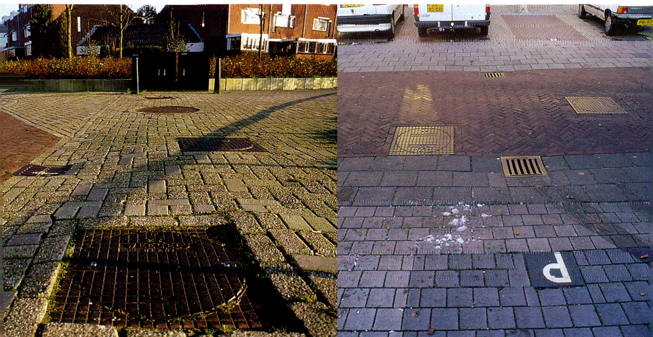
In de straten van de wijk Luchtenburg liggen veel putdeksels, ze vormen de toegang tot de pomp, slibvangput en meters.
