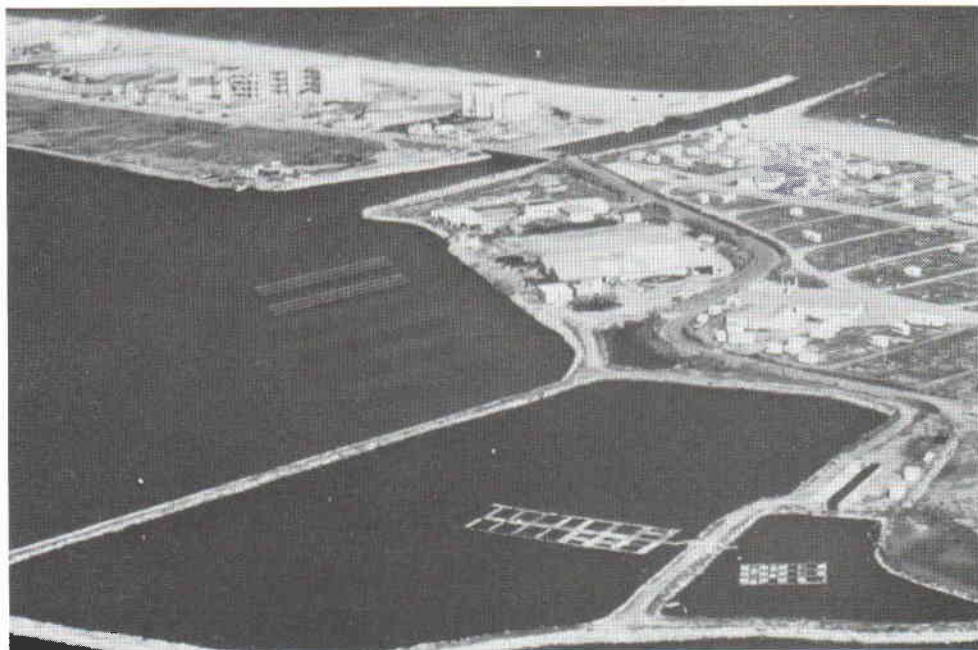
VIII - La Deva-Sud sur l'étang du Prévost à Palavas-les-flots (Hérault) : au premier plan le bassin extérieur et ses cages flottantes ; au second plan, les tables de mytiliculture, à proximité du grau
