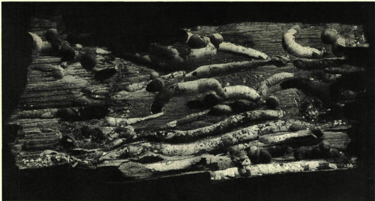
Fig. 40 B. Innenseite des in Fig. 40 A abgebildeten, von Teredo navalis L. befallenen Pfahles. — Nach ROCH; wie Fig. 40 A.
