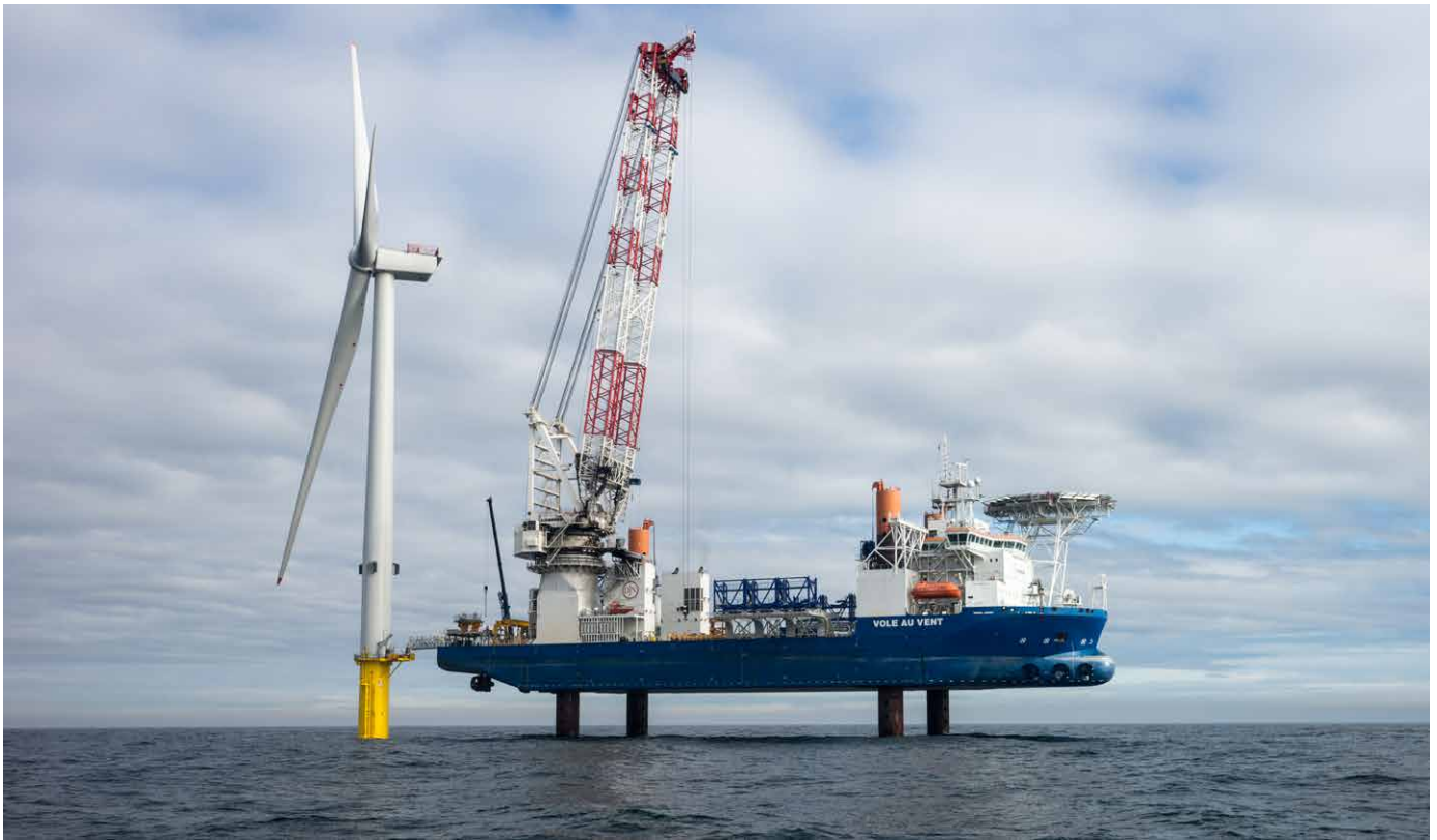
De kraan van het offshore jack-up installatieschip Vole au Vent (Jan De Nul) laat toe om op een veilige manier zware funderingen en componenten van offshore windmolenparken te installeren. © Haven Oostende
