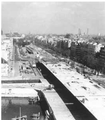
Figuur 136 Vanaf de jaren 1960 groeide een algemene sfeer pro auto en autosnelwegen. Tussen 1965 en 1975 werden aanzienlijke budgetten vrijgemaakt om in sneltempo een wegennetwerk aan te leggen. De bouw van de fly-over aan het Zuid in Gent (1972) moest de auto tot diep in het hart van de stad laten binnendringen. Hierdoor moesten 1800 mensen hun woning in Ledeberg verlaten. (Boone en Deneckere, 2010)
