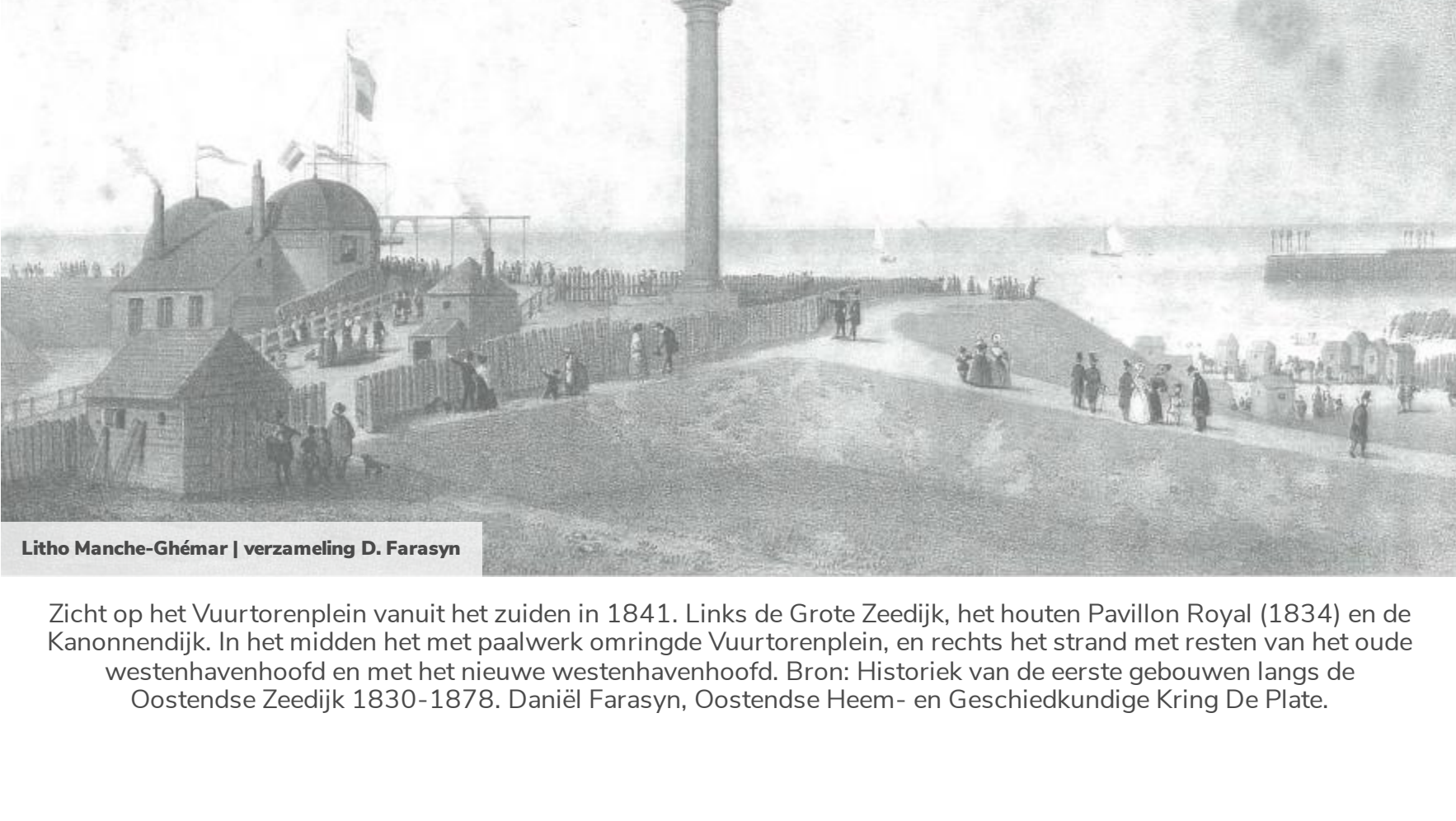
Zicht op het Vuurtorenplein vanuit het zuiden in 1841. Links de Grote Zeedijk, het houten Pavillon Royal (1834) en de Kanonrendijk. In het midden het met paalwerk omringde Vuurtorenplein, en rechts het strand met resten van het oude westenhavenhoofd en met het nieuwe westenhavenhoofd. Bron: Historiek van de eerste gebouwen langs de Oostendse Zeedijk 1830-1878. Daniel Farasyn, Oostendse Heem- en Geschiedkundige Kring De Platte.
