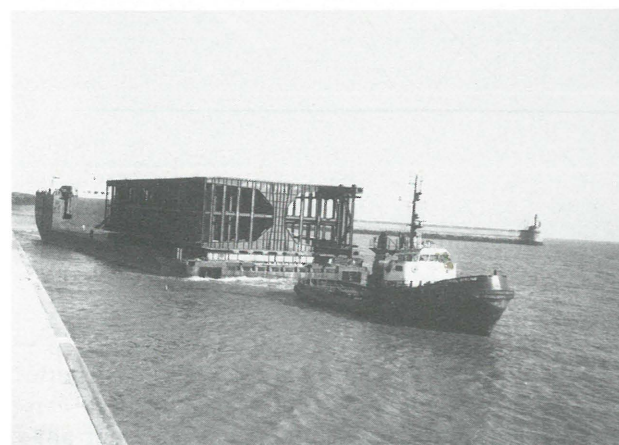
Photo 10. — Porte d'èbe de l'écluse de Zeebrugge. Transport sur ponton.
