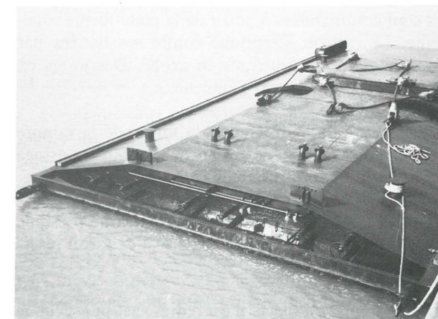
Photo 16. — Écluse de Zeebrugge. Caisson d'obturation d'une chambre de porte, hors service.
