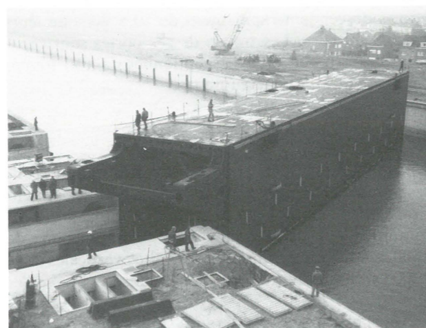
Photo 13. — Porte de l'écluse de Zeebrugge. Mise en place.
