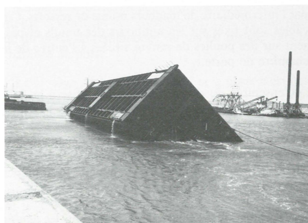
Photo 12. — Porte de l'écluse de Zeebrugge. Manœuvre de redressement.
