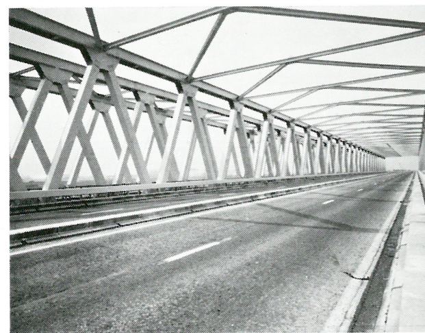
Photo 7. — Vue en enfilade du pont-route de Zandvliet avec, à l'arrière, la superstructure de pont de chemin de fer.
