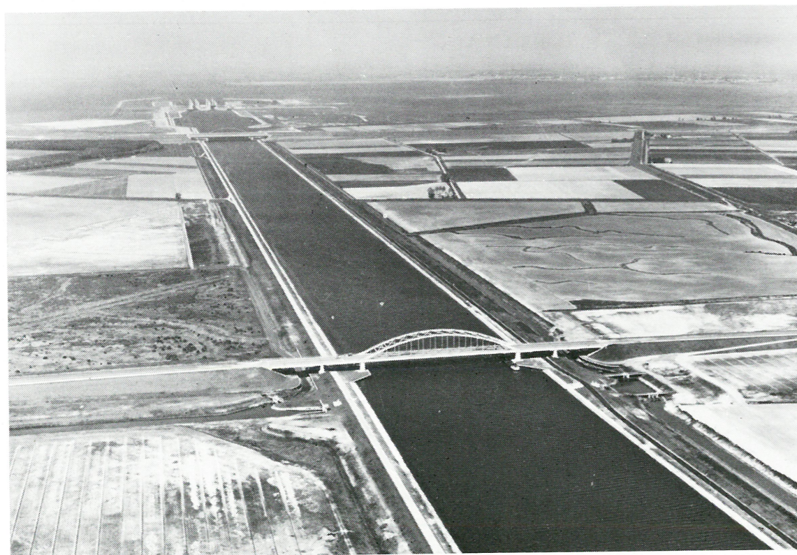
(Photo Barthofmeester - Rotterdam). Photo 3. — Vue de la plus grande partie du bief supérieur située aux Pays-Bas avec, à l'avant-plan, le pont de Bath et, à l'arrière-plan, les ponts du Kreekrakdam et l'écluse du Kreekrak.
