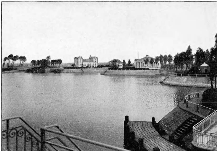
1. ÉCLUSES DE L'ARRIÈRE-PORT DE NIEUPOORT. Vue d'ensemble en 1914.
