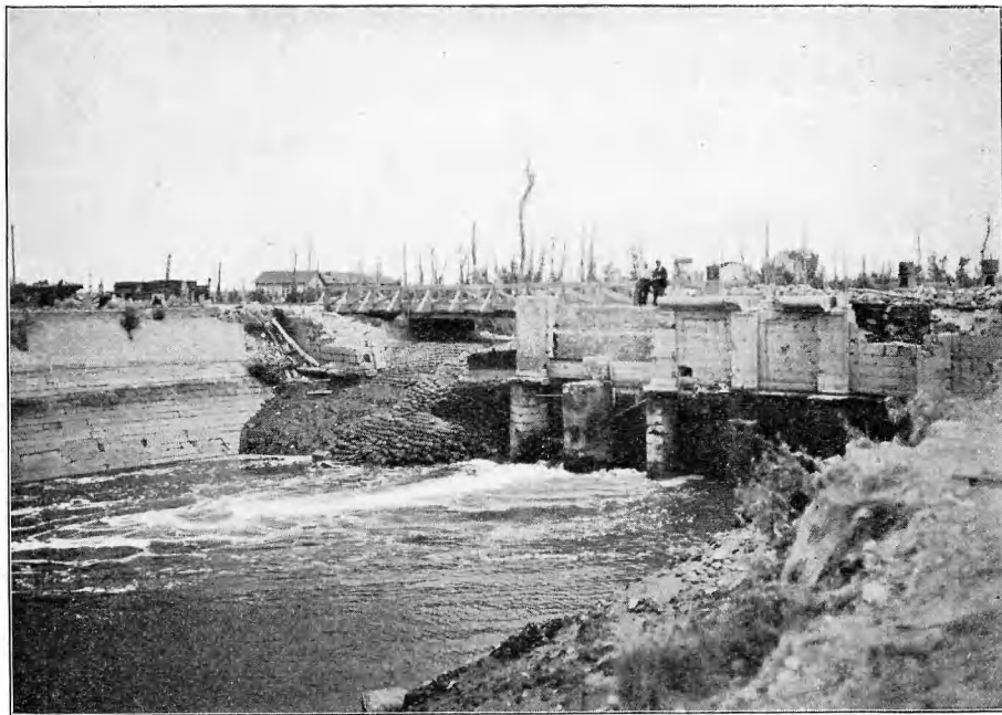
4. DÉVERSOIR DU FURNES-AMBACHT, A NIEUPOORT. Vue d'aval en 1919.
