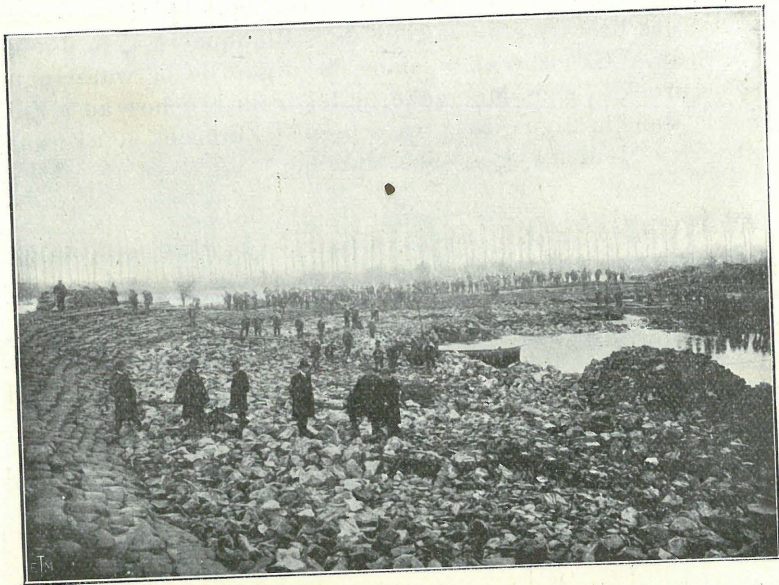
11. — Brèche de Castel. — Moerzeke. — Construction du barrage.
