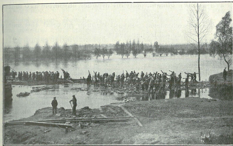
17. — Brèche de Moerzeke — Construction du barrage
