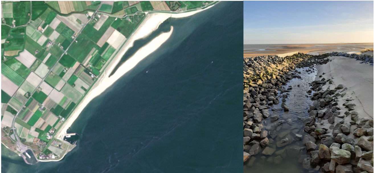
Figuur 6 Prins-Hendrikzanddijk bij Texel. Na inrichtingsmaatregelen is er met een zandtong een inham gecreëerd (links; satellietfoto van satellietdataportal.nl) waar het zoete water vanuit eenemaal gepompt wordt (rechts; foto Mardik Leopold).
