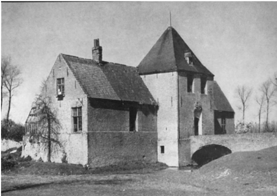
Figuur 28: Op de foto links zie je het kasteel in 1956, voor de restauratie. 129 Het kasteel in zijn huidige vorm ligt op een vierkant eiland dat mogelijk een laatmiddeleeuws concentrisch kasteel droeg. De huidige vorm is 17 e -eeuws, met 18 e -eeuwse en 20 e -eeuwse toevoegingen.
