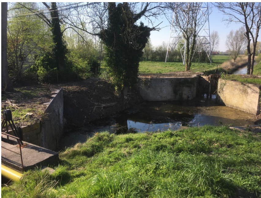
Figuur 50: de huidige sluisstructuur van Twee Speyen, daterend uit 1906. De kleine sluisdeuren duiden aan dat schepjes die deze sluis aandeden vrij smal waren, en wellicht kleinere puntschuiten waren.
