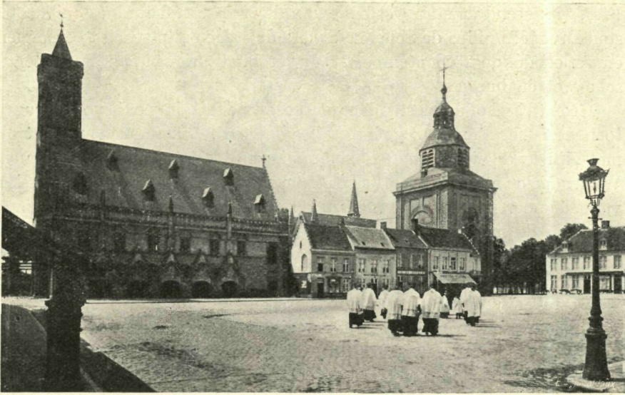
HALLEN TE NIEUWPOORT, VÓÓR DEN OORLOG (Foto Nels).
