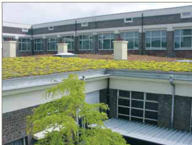
figuur 12: Zicht op het groendak
