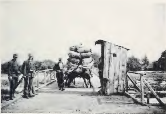
FRONTIER BRIDGE, BISTRITZA RIVER
