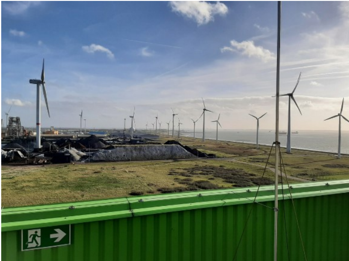
Figuur 4 Zicht op de Westerschelde richting Borssele/Ellewoutsdijk vanaf het dak van een van de twee generatorgebouwen.
