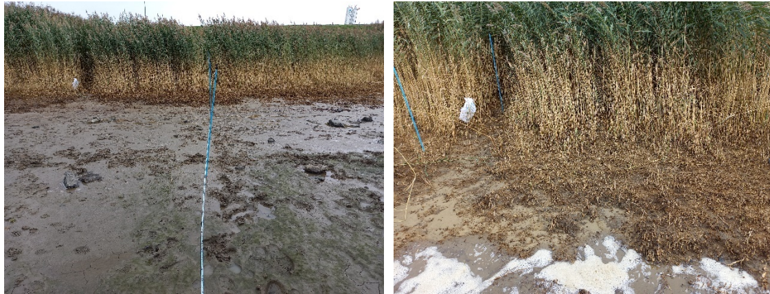
Figuur 33 Weergave van raai GSh, gefotografeerd van laag naar hoog (proefvlak 10 naar 1) (links) en een detail van de overgang naar het rietland (proefvlak 7) met door erosie blootliggende rietwortels (rechts) (23/09/2022).
