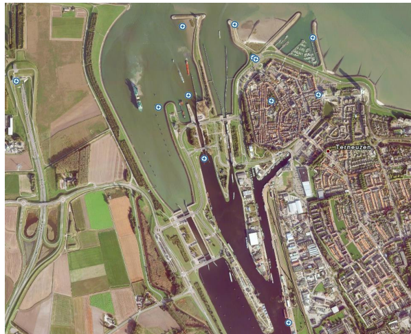
Figuur 1.1: Overzicht sluisencomplex Terneuzen
