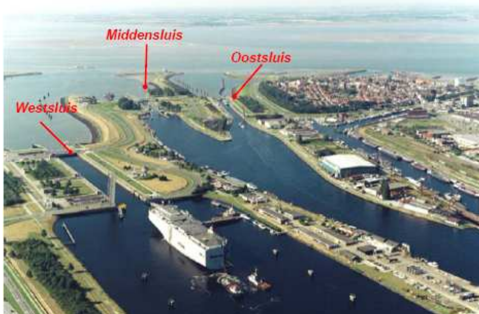
Figuur 2: Overzicht Sluizencomplex Terneuzen
