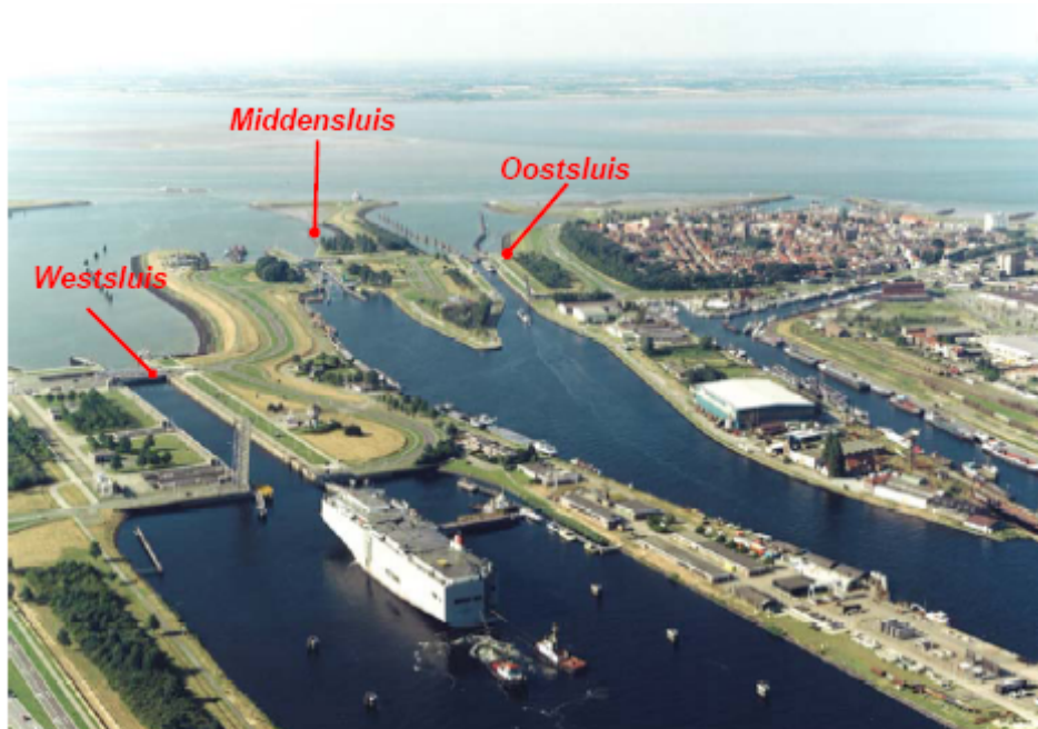
Figuur 2: Overzicht Sluizencomplex Terneuzen
