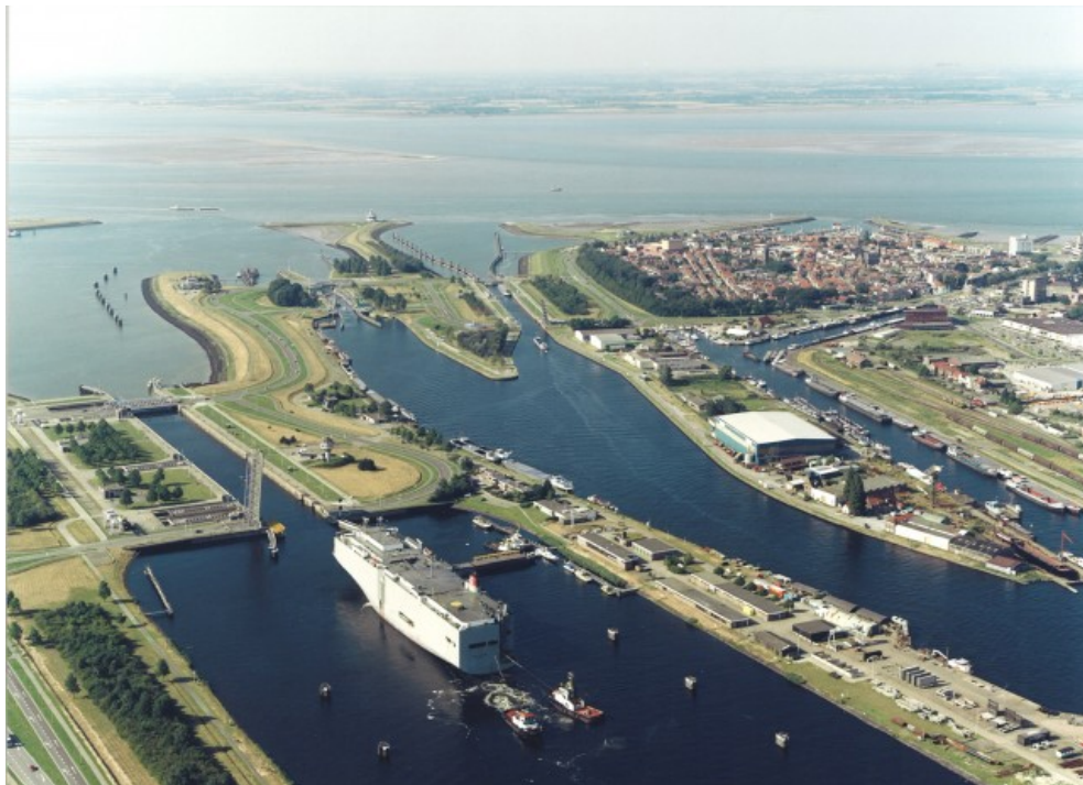
Figuur 51: Sluizencomplex Kanaal Gent-Terneuzen ( www.kgt.2008.nl )
