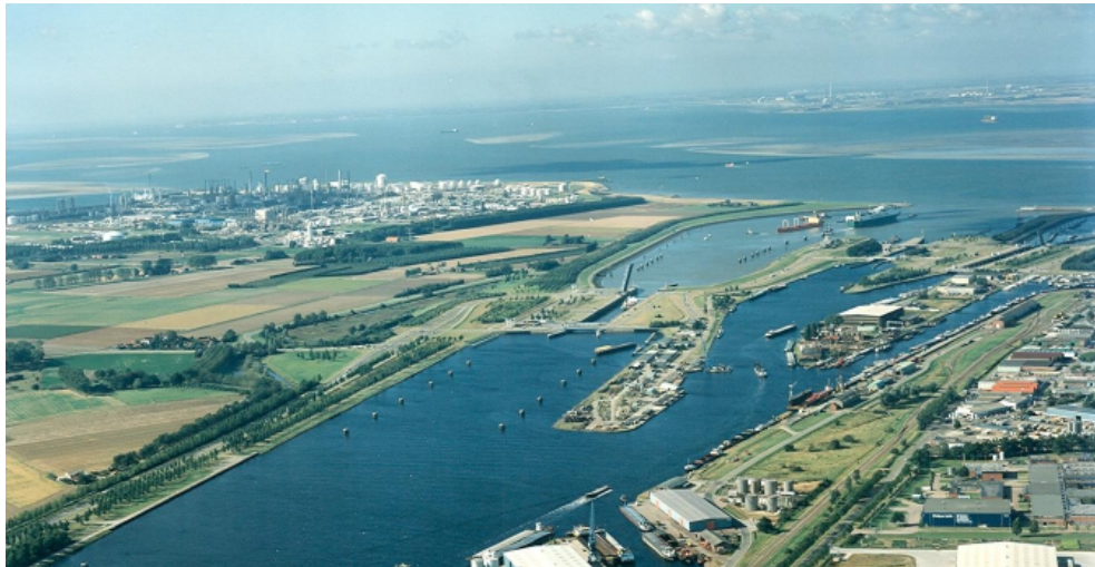
Figuur 50: Sluizencomplex Kanaal Gent-Terneuzen ( www.scheldenet.nl )
