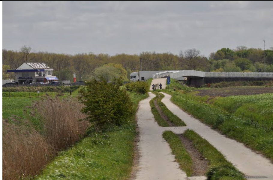
Zone 2 - Pad langs de Maeredijk, ten N van Kanaal Nieuwpoort-Duinkerke
