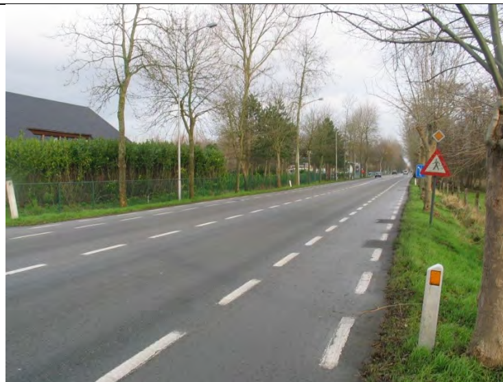
Zone 9 – Koksijde, R. Vandammestraat tussen de Fluithoek van de Noordduinen
