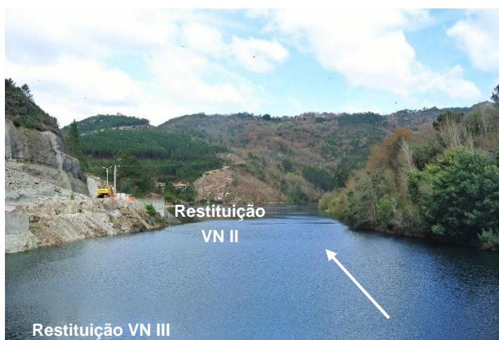
Fig. 17 – Zona de restituição de Venda Nova II e III (março de 2016)
