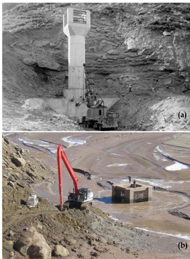
Figura 2. Tomada de água da barragem de Paonia (a) durante a construção, em 1961 (U.S. Bureau of Reclamation); (b) em 2014 (Subcommittee on Sedimentation of ACWI)
