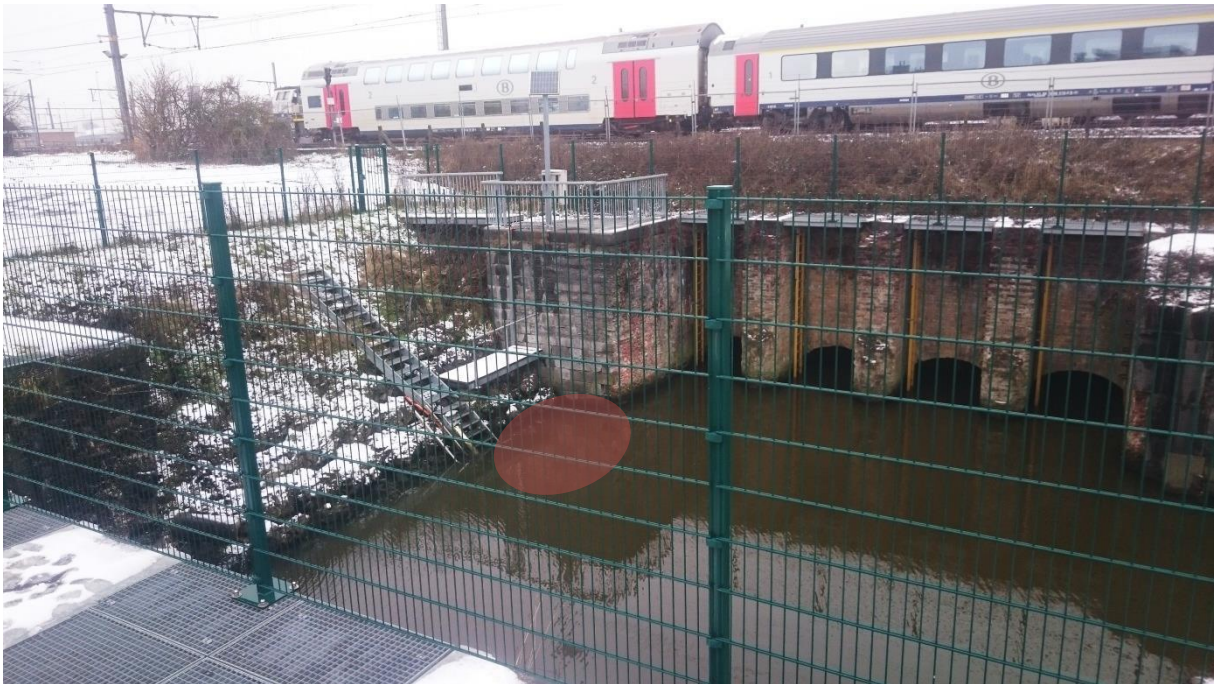
Figuur 17. Zicht op het begin van de ondergrondse koker vanop de duiker net stroomafwaarts het terugslagkleppencomplex van het Caemerlinckxgeleed. De artificiële substraten werden tussen de trap en de bakstenen oever geplaatst (rode cirkel).
