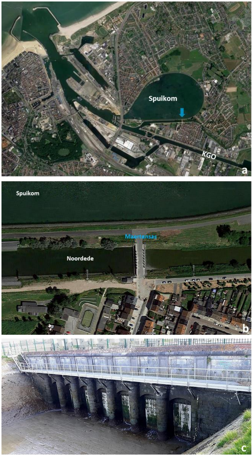
Figuur 4. Situering van het Maertensas op de Noordede te Oostende (a,b). Tijdens springtij kan de stroomafwaartse zijde van het Maertensas gedeeltelijk droogvallen (c, foto Maarten Goegebeur (VMM), 30/03/2017).
