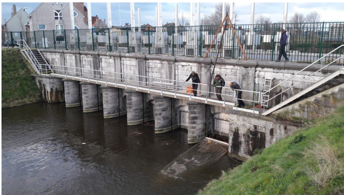
Figuur 5. Zicht op de stroomopwaartse zijde van het Maertensas tijdens de bemonsteringen van 2019. Het in de sponningen van de vismigratiespui aangebrachte gemaalnet is hierbij in werking waarbij alle binnenkomende glasalen (en andere organismen) werden afgevangen.
