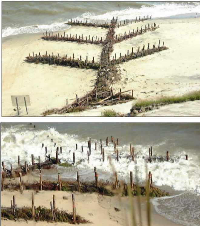
Figure 8. SEMS ( Système des Épis Maltais Savard ) groynes used in the St. Lawrence Estuary (Canada), using fir stakes (©Photo: N. Roy).
