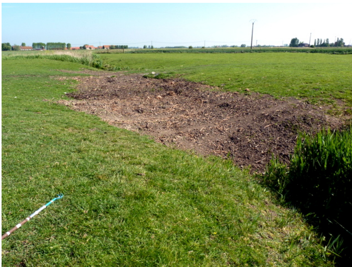
Fig. 130 - Een gedeelte van segment 800 werd zonder vergunning opgevuld met gronden afkomstig uit de ruiming van segmenten 482 en 478. Foto LV P1130440, 4/06/2015, zuidoostelijke gedeelte van segment 800.
