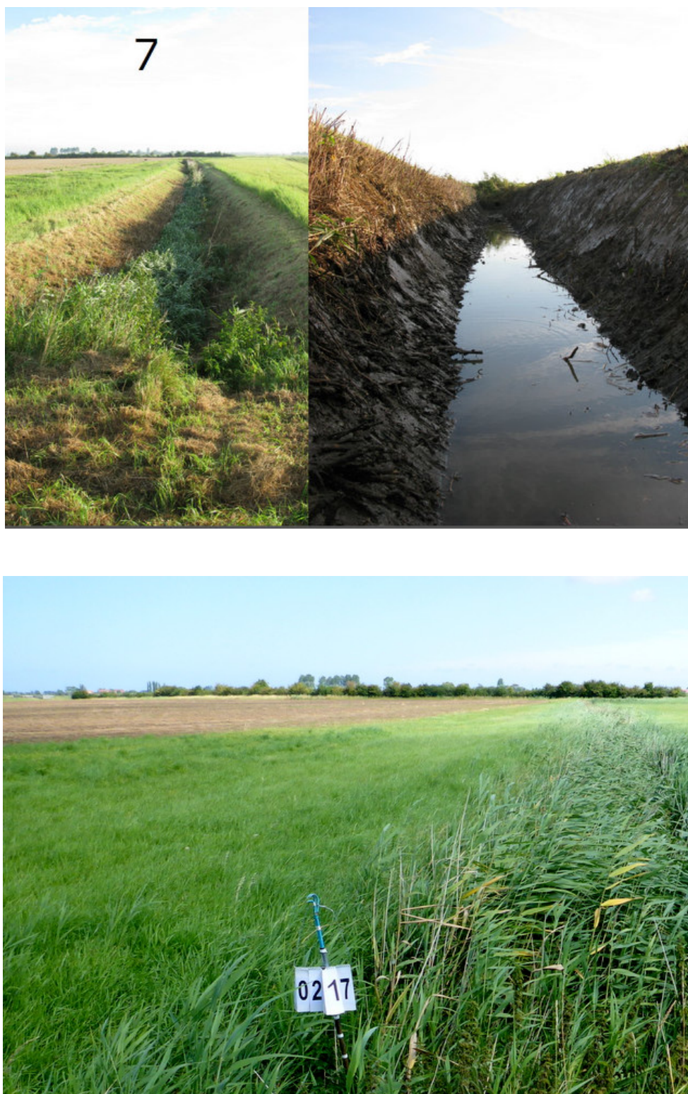
Fig. 147 - De ruiming van sloten-cluster 7 in de Bladelingshoek (segmenten 215pp, 216 en 217). Boven: vóór en na de ruiming in 2011 of 2012 (Bron K. De Bus). Onder: situatie in 2015 van segment 217 (Foto LV P1000828, 4/08/2015). Alle segmenten in deze cluster bestaan uit een dichtgegroeide, jonge, vitale Rietkraag. Heel plaatselijk (10 -15 m) is er een open gedeelte gedomineerd door vier kroossoorten, Fijn hoornblad, Gewoon kranswier,... (op en onder water) en lage verlandingssoorten als Slanke waterkers, Heen en Watertorkruid. De segmenten worden langs beide zijden begrensd door maaigras (akkerrandbeheer). Het is niet duidelijk of de segmeneten over hun volle lengte gedolven werden of als het nu open gedeelte inmiddels heruitgegraven werd.
