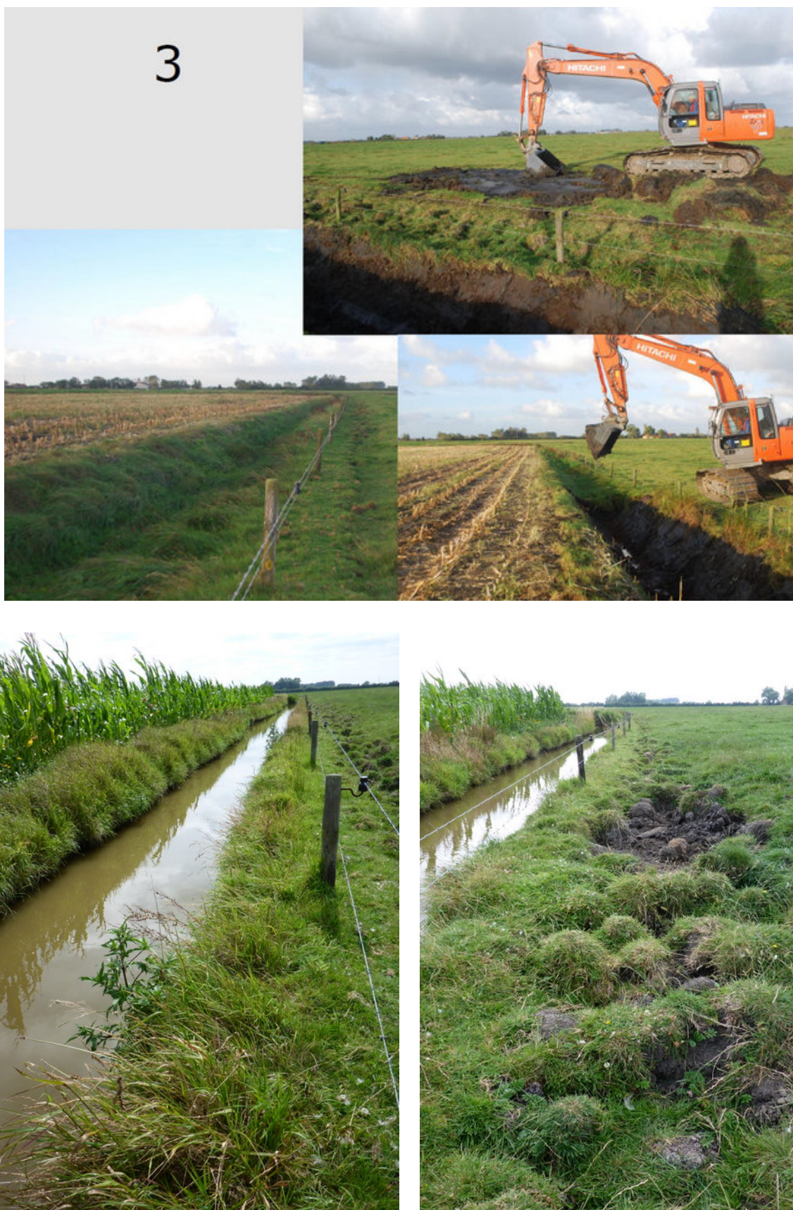
Fig. 143 - De ruiming van sloten-cluster 3 in de Bladelingshoek (segment 305). Boven: vóór en na de ruiming in 2011 of 2012 (Bron K. De Bus). Onder: situatie in 2015 (Foto's LV P1010338 en P1010339 ,10/08/2015). Het slotwater is troebel (klei-suspensie? ) en watervegetatie ontbreekt, maar het micro-reliëf op de oever bleef goed bewaard.
