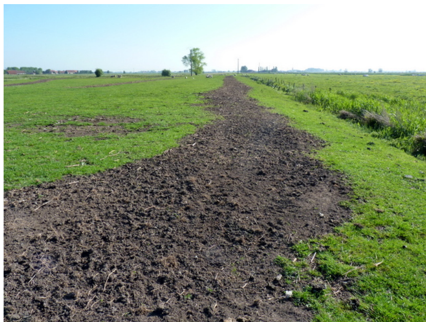
Fig. 137 - Goede depositie van ruimingsslib. Deze foto van de ruiming van een slootsegment in de centrale gedeelte van de komgronden illustreert goed hoe de geruimde gronden voldoende ver van de bermschouder van de sloot kunnen gedeponeed, en vervolgens over het land kunnen uitgespreid worden zonder gevaar voor de eventuele aandachtsoorten in de natte oeverzone en de schouders van de slootbermen. Foto LV P1130415, 4/06/2015, segment 490.
