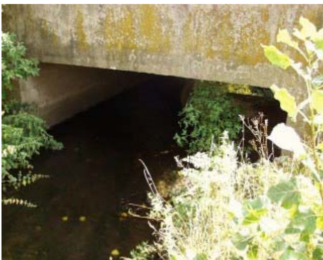
Natte sectie brug Bosbeek (zicht stroomafwaarts)
