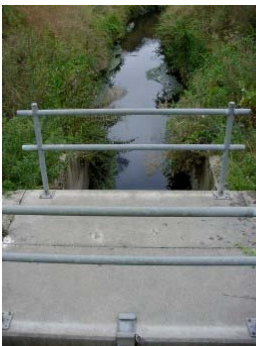
Duiker onder winterdijk Kogbeek (zicht stroomafwaarts)
