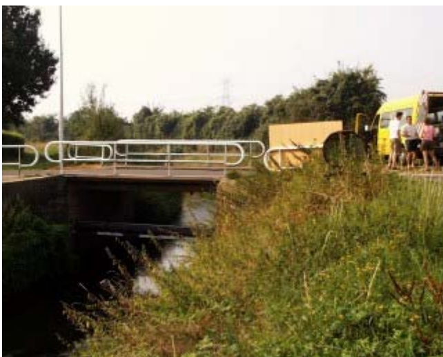
Brug Abeek stroomopwaarts monding (zicht stroomafwaarts)
