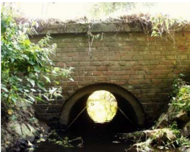
Koker stroomopwaarts monding Kogbeek (zicht stroomopwaarts)
