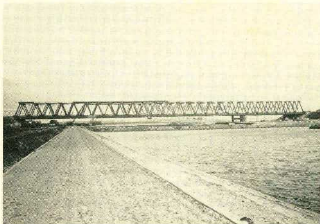
Zandvliet : Double pont rail-route au-dessus du canal de la liaison Escaut-Rhin.
