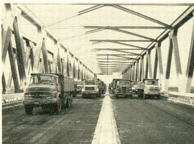
Vue en enfilade : à gauche superstructure du pont-rail. Algemeen uitzicht : links, de bovenbouw van de spoorbrug.
