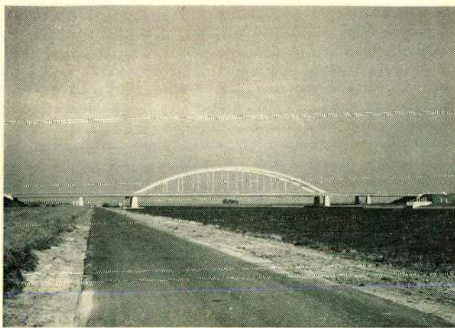
Pont bowstring sur le canal Escaut-Rhin à Bath (Pays-Bas).
