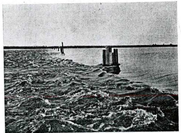
Fig. 10. — Photo prise de l'aval vers la Grande Ile Mateba. Palplanche haute d'avant plan n°s 537-534. Palplanche haute du large n° 484.
