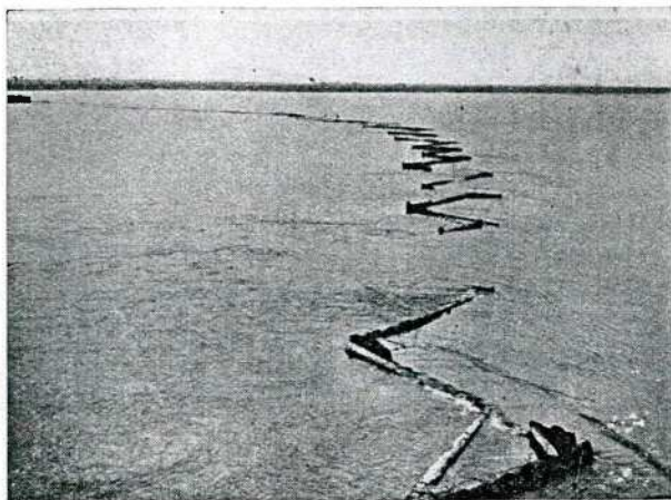
Fig. 5. — Barrage de Mateba (fin août 1934). — Vue de l'Ilot I vers le large. — Décrochements et étançonnement des sections du rideau normales au courant.
