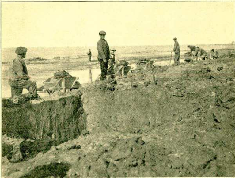
Figuur 16. Het ontgraven van den verschoven keileemdam op het Balgzand.
