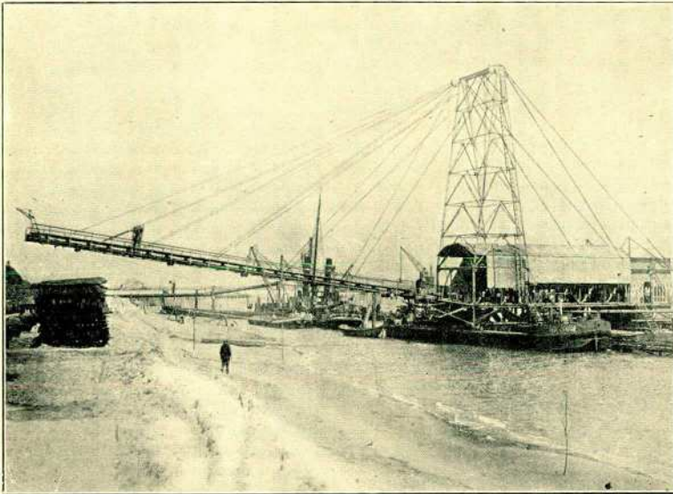
Figuur 37. Transporteur voor het aanbrengen van bekleedingsgrond, werkzaam op het Kornwerderzand, Juli 1927.
