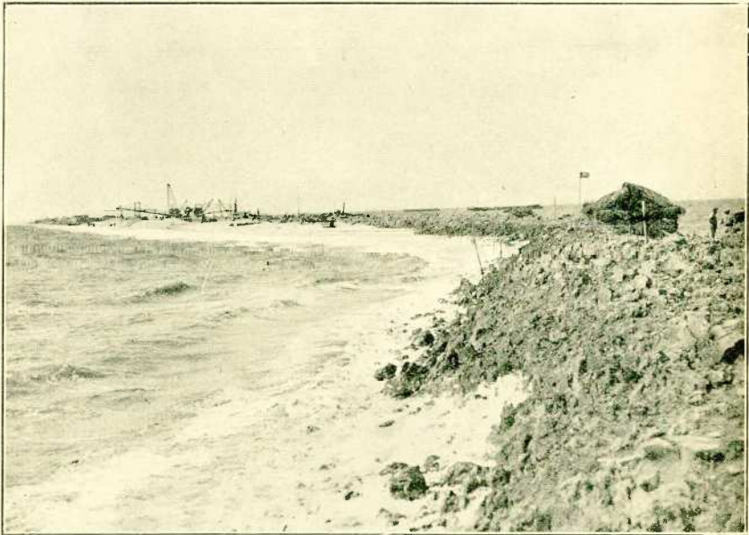
Figuur 53. Aanleg van den Wieringermeerdijk op de Oude Zeug, nabij den hoek in den dijk, van de west- of binnenzijde gezien.
