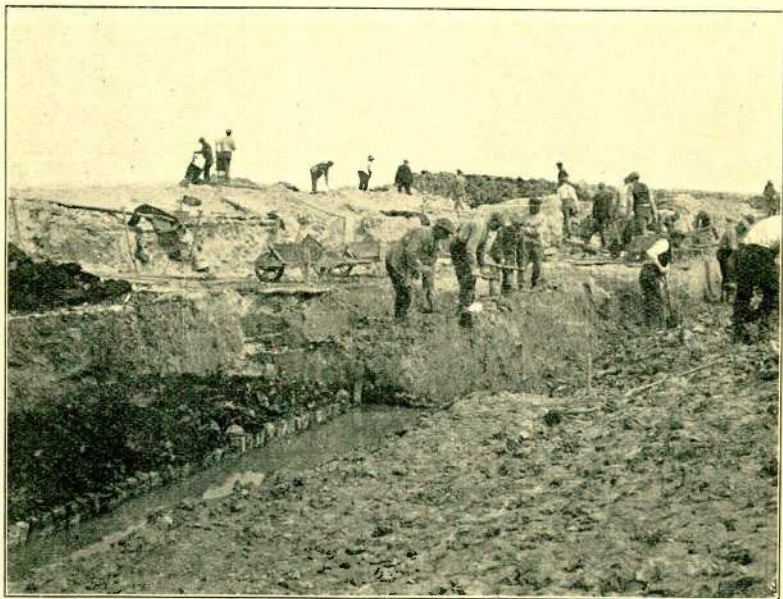
Figuur 17. Ontgraving voor den aanleg van den dijksteen in den opgepersten grond op het Balgzand.
