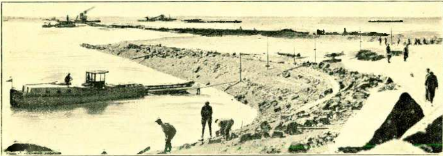
Figuur 15. Het sluitgat van den dijk door het Amsteldiep na het opwerpen van den keileemdamm.
