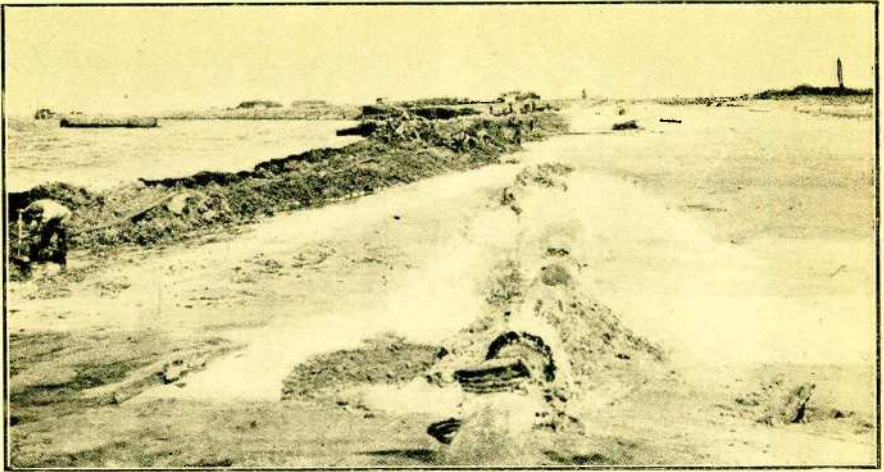
Figuur 11. Het opspuiten van het zandlichaam achter den keileemdam in het sluitgat van den dijk door het Amsteldiep.
