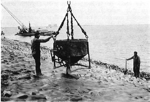
Taludbescherming in de haven van Rotterdam. Gietasfaltpenetratie met kubel (stortbak). Protection de berge dans le port de Rotterdam. Pénétration à l'asphalte coulé avec bac verseur.
