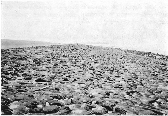
Zware stortsteenpenetratie op het werkeiland Neeltje Jans in de Oosterschelde (werk Rijkswaterstaat).
